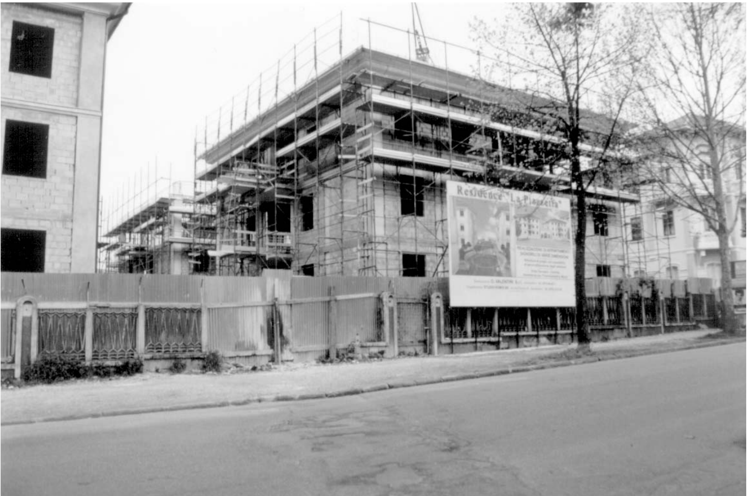
Oarticolare della COSA (4 fabbricati) che l'ha sostituita
